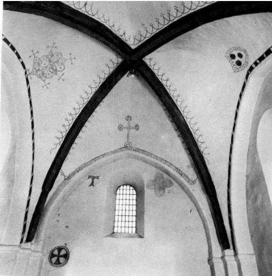
Fig. 12. Korets hvælv og østvæg med sengotiske kalkmalerier (s. 1697). NE fot. 1977. - The chancel vault and east wall with Late Gothic wall-paintings.
