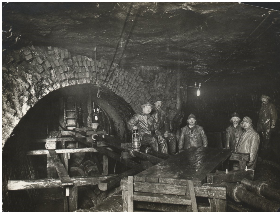
Arbejdere i tunnelen under inderhavnen fra Havnegade til Gammel Dok. Mariboers Samling, 1914 Københavns Museum
