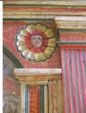
Figur 7.1.28. Kundby Kirke. Duppet og pisket rød lasur på gul bund på alterbordspanel. Som fig. 7.1.27. Kundby Kirke, Tuse herred, Holbæk amt. Udenfor undersøgelsens kirker.
