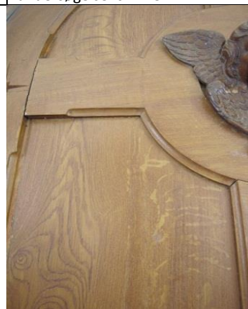
Figur 7.4.85. Ådret sakristidør i Ejby Kirke, Ramsø herred, Københavns amt. Udenfor undersøgelsens kirker. Årer er mørkere pigmenteret end lasurer. Lyse årer er trukket i lasuren og synliggør underliggende lys bundfarve.
