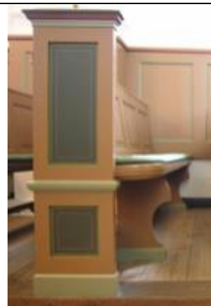
Figur 7.5.64. Stoleværk med bemaling fra 1983 i lys rødbrun hovedfarve og brun og lysegrå bifarve. Ejby Kirke, Ramsø herred, Københavns amt. Undersøgelsens landsdækkende kirker.
