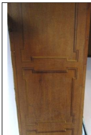
Figur 7.4.131. Mørke og lyse skygge- lister malet med stregtrækninger for at imiteret fyldingspanelværk. 1865. Opgangstrappe til pulpitur. Halsted Kirke, Lollands Nørre herred, Maribo amt. Udenfor undersøgelsens kirker
