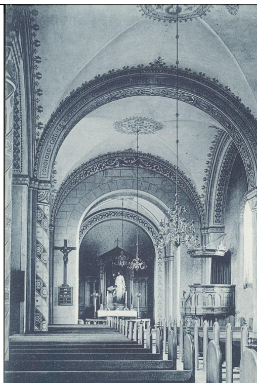
Figur 7.4.156. Interiør med dekorationsmaleri fra 1875 på hvælv og vægge, i mens triumfvæggen har malede kvadre. Ugerløse Kirke, Merløse herred, Holbæk amt, undersøgelsens region Holbæk-Frederiksborg.
