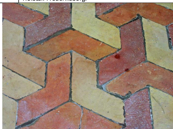
Figur 7.4.158. Detalje af gulvbelægning fra interiør restaurering i sidste del af 1800-tallet i Engestofte Kirke, Musse herred, Maribo amt, udenfor undersøgelsens kirker.
