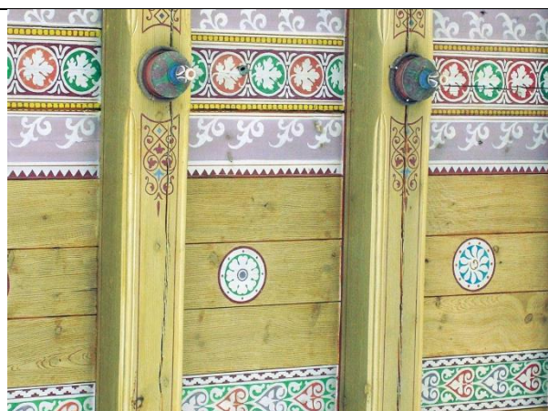
Figur 7.4.157. Detalje af lys hvidlig ådring fra 1862 med dekoration på bjælkeloft. Tyrstrup Kirke, Sønder Tyrstrup herred, Haderslev amt. Udenfor undersøgelsens kirker.
