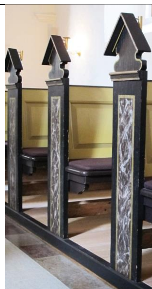
Figur 7.3.90 Stolegavle med sort hovedfarve, gul kontur og rødbrun marmorering på gavlfelt. Marmorering afdækket, dele af gavlenes sorte er afdækket eller rekonstrueret. Auning Kirke, se fig. 7.3.89.
