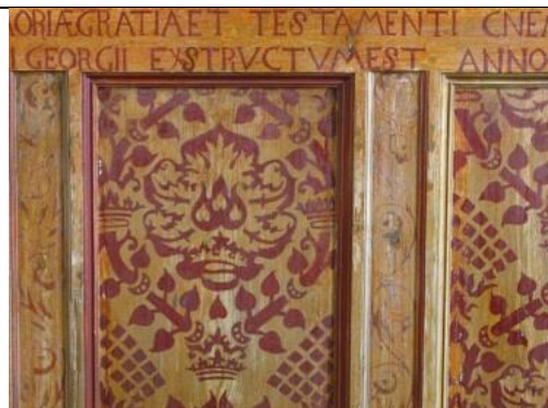
Figur 7.1.37. Alterbordspanel med delvist rekonstrueret skabelonmalet brokademotiv fra 1603. Menes udført med lasurfarve på laseret kridtgrund. Ønslev Kirke, Falsters Nørre herred, Maribo amt. Udenfor undersøgelsens datagrundlag.
