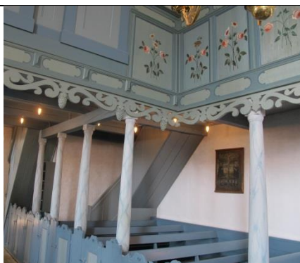
Figur 7.3.128. Detalje af pulpitur med bemaling fra 1734 i blåt farveudtryk. Søjler er marmorerede, rammeværk er lyseblå og fyldinger har blomstermaleri på lysegrå bundfarve. Ballum Kirke, Tønder Lø herred, Tønder amt, udenfor undersøgelsens kirker.
