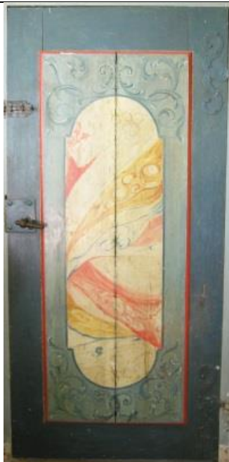
Figur 7.3.28. Fantasi marmorering med røde, rødgyldne og blå årer på hvid bundfarve. Afdækket. Sakristidør i Højer Sankt Peder Kirke, Tønder herred, Tønder amt, undersøgelsens landsdækkende kirker.
