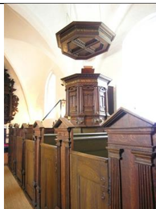
Figur 7.4.72. Foruden altertavle er prædikestol og stole ætset, bejdset og lakeret. Glim Kirke, Sømme herred, Københavns amt.
