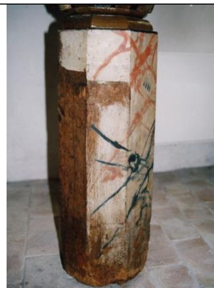
Figur 3.1. 1600-tals bemaling, der er malet uden om et nu nedtaget stolestaderyglæn. Prædikestolsstolpe til prædikestol i Frederikssund Kirke, Lynge-Frederiksborg herred, Frederiksborg amt.
