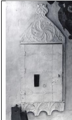
Figur 7.4.19. Kalket vægskab. Skabet er indsat i muren og har været overstrøget med hvidtekosten. Torkilstrup Kirke, Falsters Nørre herred, Maribo amt. Foto fra Antikvarisk-Topografisk Arkiv
