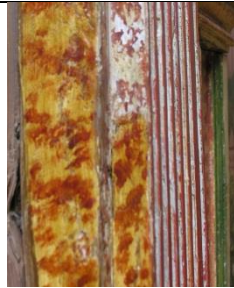
Figur 7.1.27. Detalje af påduppet marmorering i rødbrun på laseret bund, fra rammeværk på alterbordspanel. Har aldrig været overmalet. Kundby Kirke, Tuse herred, Holbæk amt. Udenfor undersøgelsens kirker.
