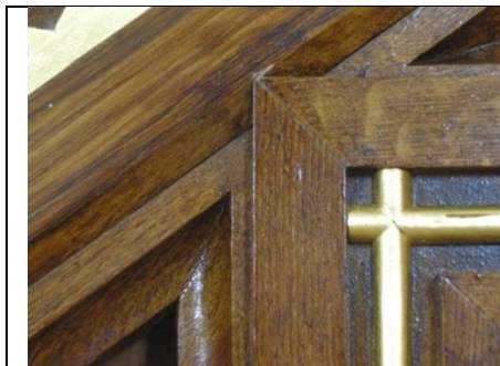
Figur 7.4.86. Detalje af prædikestol med ådring fra 1856. Penselføringen illuderer snedker-samlinger. Alt kirkens inventar blev ådret i 1856. Engestofte Kirke, Musse herred, Maribo Amt.
