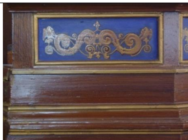
Figur 7.4.12. Kunstig Ultramarin anvendt som baggrundsfarve for dekoration i prædikestols frisefelt. Rammeværket er mørkt mahogni-ådræt. Uovermalet farveudtryk. Brylle Kirke, Odense herred, Odense amt. Udenfor undersøgelsens kirker.
