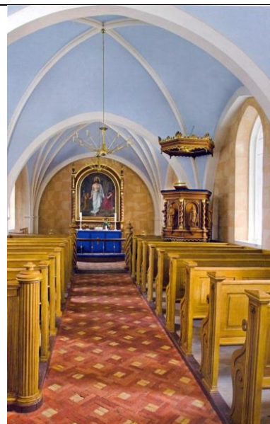
Figur 7.1.154. Interiør-farveskema fra 1862 efter restaurering i 2007 med gulvet, stoleværkets ådring, prædikestolens brune farveudtryk og østvæggen i deres oprindelige 1862 farveudtryk, imens hvælvenes blå er genskabt efter spor fra oprindelige blå farve. Ulse Kirke, Fakse herred, Præstø amt, undersøgelsens landsdækkende kirker.
