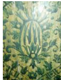
Figur 7.1.38. Detalje af skabelonmaleri fra 1500-tallets sidste del med grøn lasurfarve på lys, grønt laseret bundfarve på alterbordspanel. Afdækket og delvist rekonstrueret. Ganløse Kirke, Farum herred, Frederiksborg amt. Udenfor undersøgelsens datagrundlag
