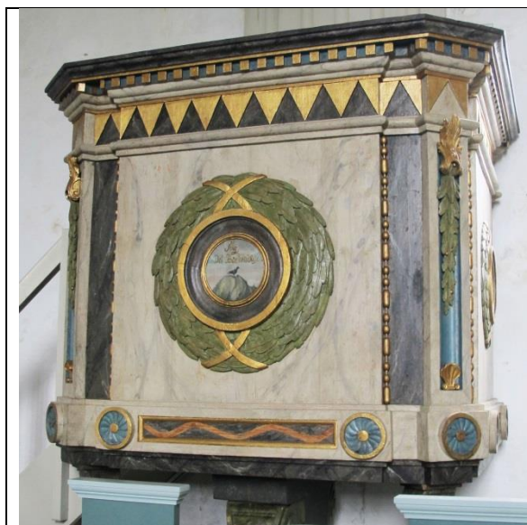
Figur 7.3.105. Bemaling fra 1790 i gråt farveudtryk med lysegrå og mørkegrå marmoreret hovedfarve, samt blå lustre, forgyldning og sort marmorering som bifarve på prædikestol. Afdækket. Skjoldborg Kirke, Hundborg herred, Thisted amt, undersøgelsens region Thisted.
